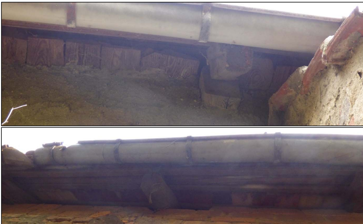
Abb. 7: Beispiele für Dachüberstände mit Nischen oder offenen Stellen am Wohnhaus
