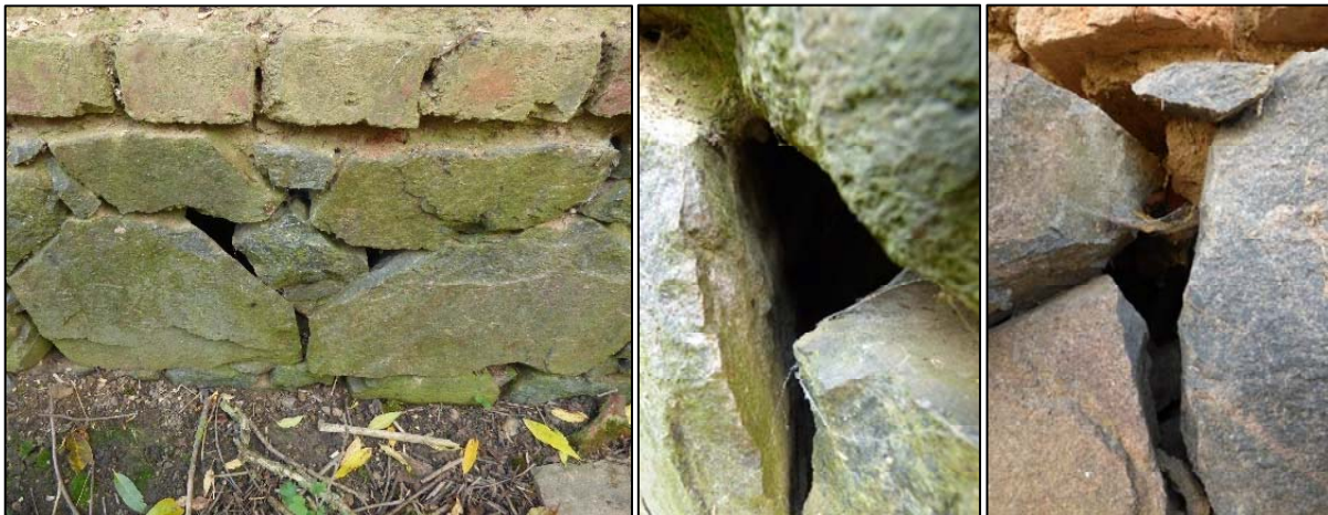
Abb. 17: exemplarische Bilder von Nischen und Hohlräumen im Natursteinverband der Fassade des Seitengebäudes
