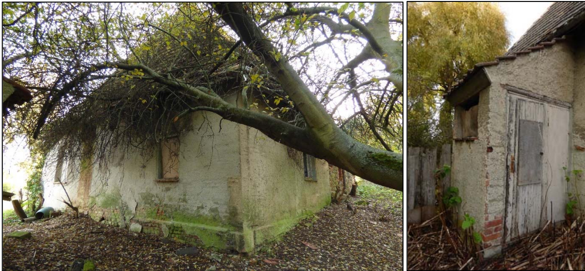
Abb. 4: Außenansichten der hinteren Fassade des Wohnhauses (Nordostseite); Anbau / Seiteneingang an der südwestlichen Hausseite
