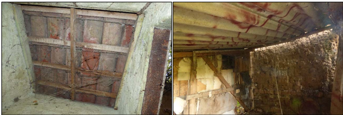
Abb. 20: Dach in der Trockentoilette (links) und Blick in die Bude (rechts)
