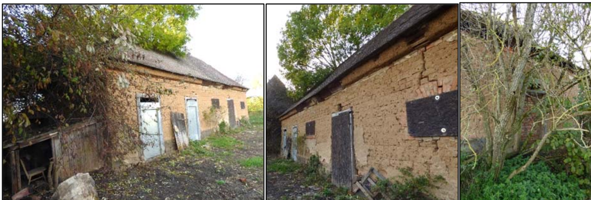
Abb. 15: Außenansichten des Seitengebäudes (Fassaden: Südost zweimal, Nordost)
