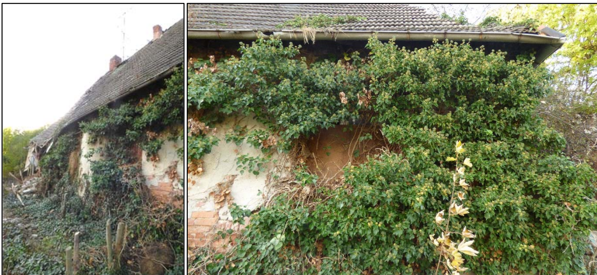
Abb. 5: Außenansichten der vorderen Fassade des Wohnhauses (Südostseite) im östlichen Bereich
