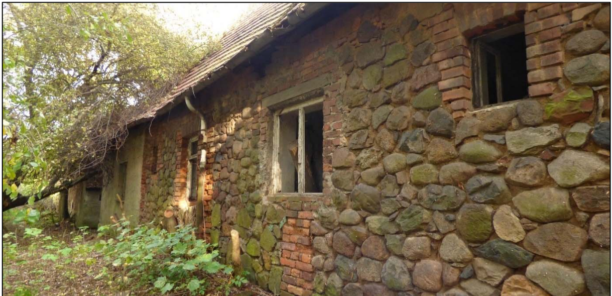
Abb. 3: Außenansichten der hinteren Fassade des Wohnhauses (Nordwestseite)
