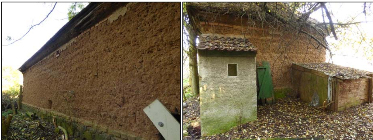
Abb. 14: Außenansichten des Seitengebäudes (Fassade Nordwest; Fassade Südwest mit Anbauten)
