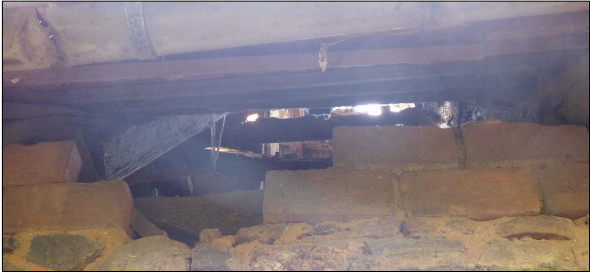
Abb. 8: Beispiele für Dachüberstände mit Nischen oder offenen Stellen am Wohnhaus
