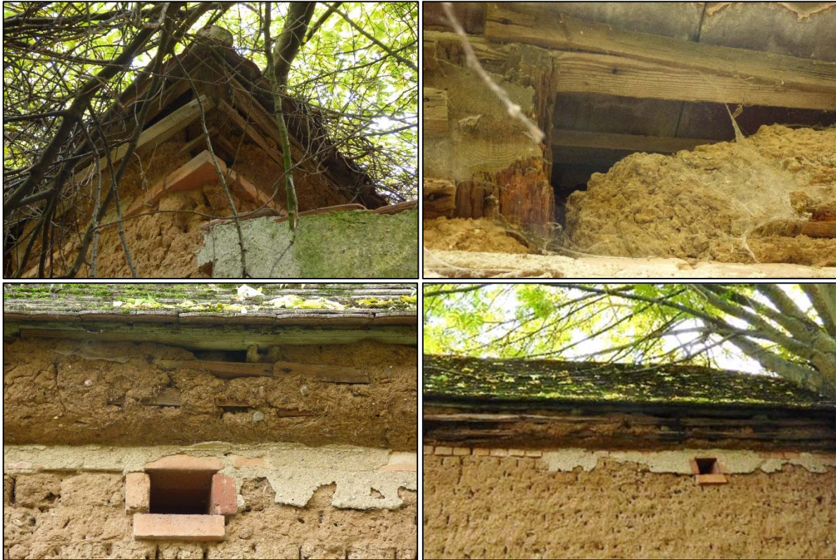
Abb. 16: Nischen und Höhlen an den Dachüberständen sowie Öffnungen zum Gebäudeinneren
